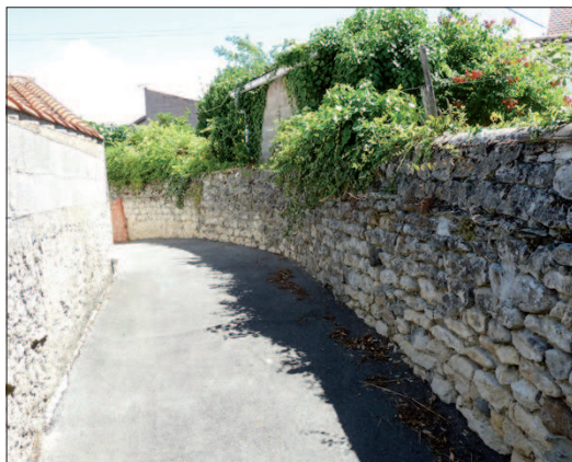
Mur en moellons
