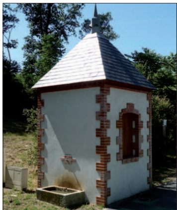
Fontaine ferrugineuse restaurée
