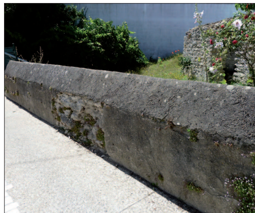
Mur en moellons enduit à la chaux
