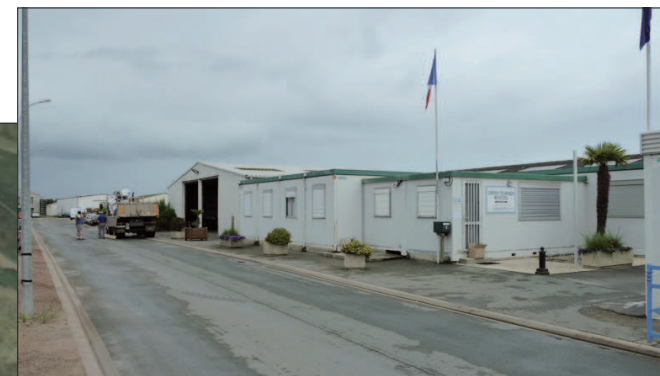
Accès atelier - bureaux
