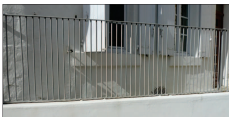
Grille à barreaux fer
