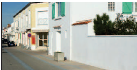
Mur enduit blanc
