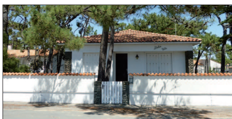
Mur enduit (blanc)
