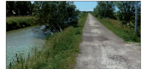
Chemin rustique en terre et remblai
