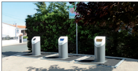
Bornes recyclage enterrées
