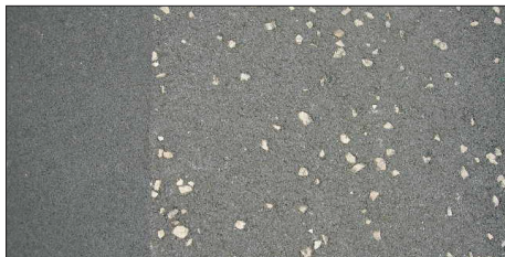
Enrobé noir (+ cloutage)
