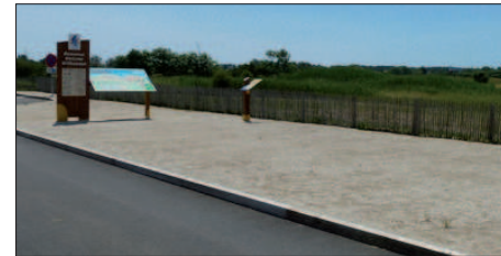
Stabilisé simple «sablé»
