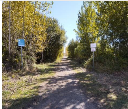
Photo de la sortie du camping Les Rouillères côté mer et RNN au niveau où doit être construit la nouvelle digue et où se situera la rampe qui «l'enjambe».
