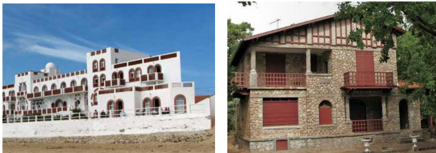
Exemples de patrimoine bâti balnéaire typique de la côte vendéenne
