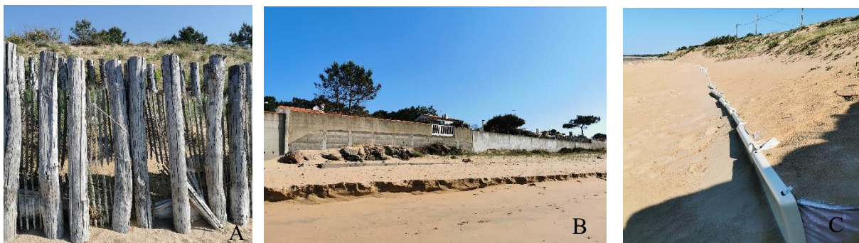
Figure 9 : Photo du Bois-paille cumulé à des ganivelles (A), un mur de béton (B) et les Waves Bumper (C) © Clément André
